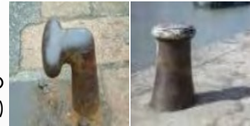
BOLLARD (SUR LE QUAI)
